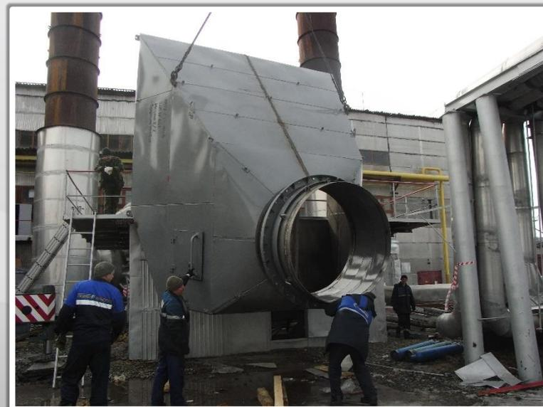
Монтаж ВОУ ГТК-10-4, ВОУ ГПА-Ц-16 и шахты выхлопа ГПА-Ц-16 на КС Хасырейской, КС Пангодинской и КС Ныдинской ООО «Газпром трансгаз Югорск»
